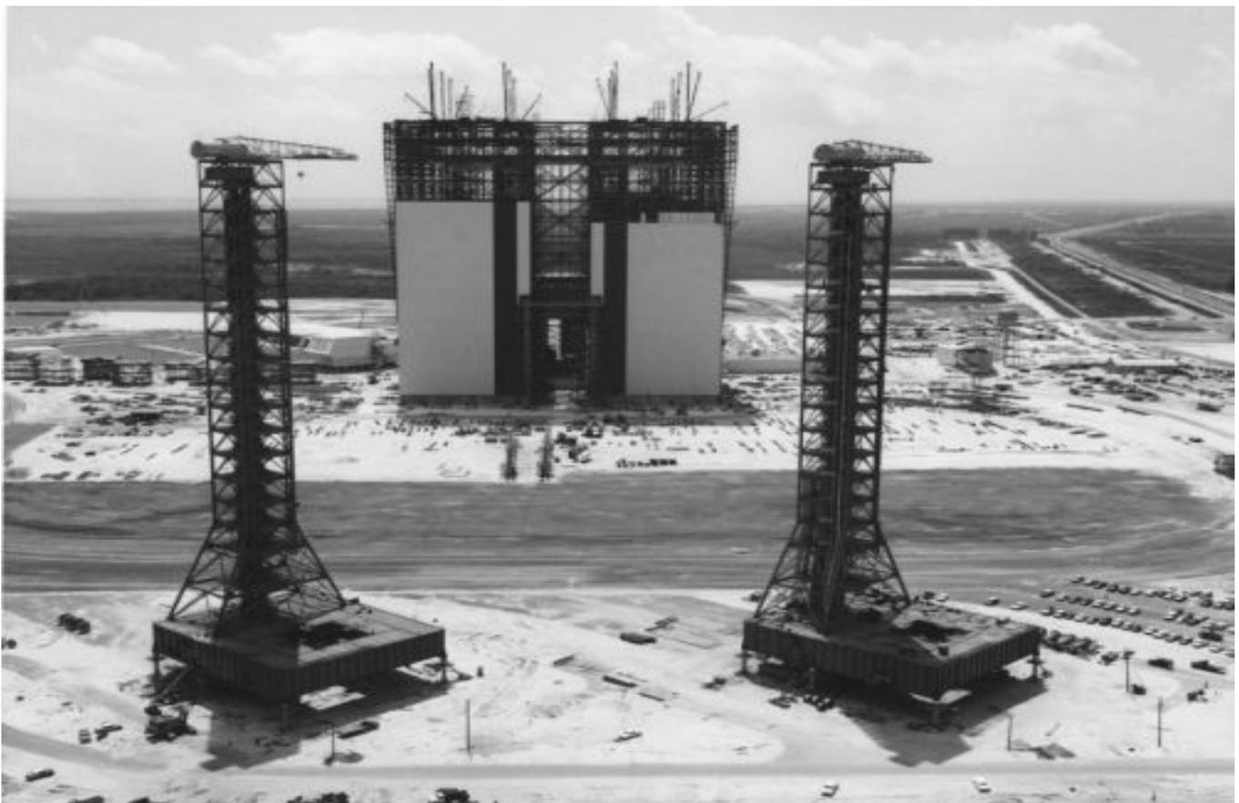
При строительстве здания были израсходованы 89 421 тонн стальных конструкций и 49 696 м<sup>3</sup> бетона. Для вентиляции здания используются 125 вентиляторов, внутри смонтированы 71 кран и два мостовых крана грузоподъемностью 227 тонн.
